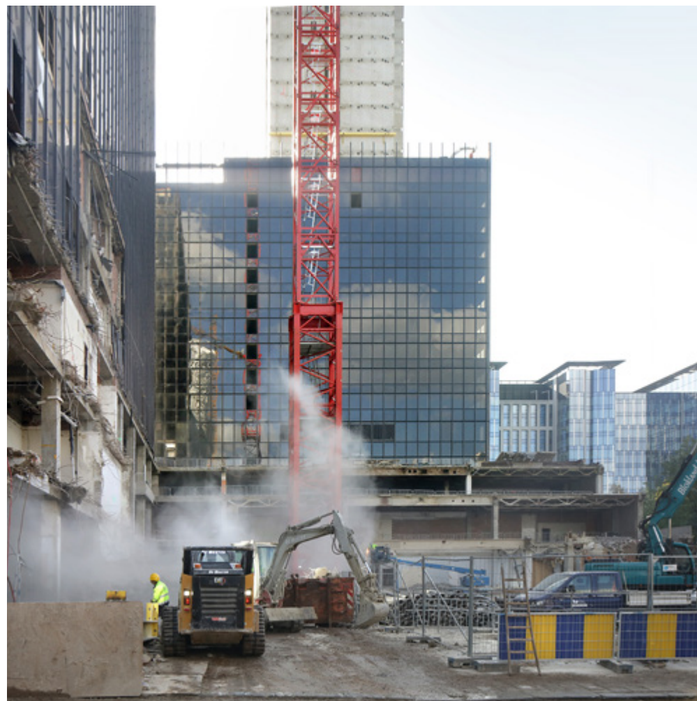
Chantier ZIN - Bruxelles quartier Nord
