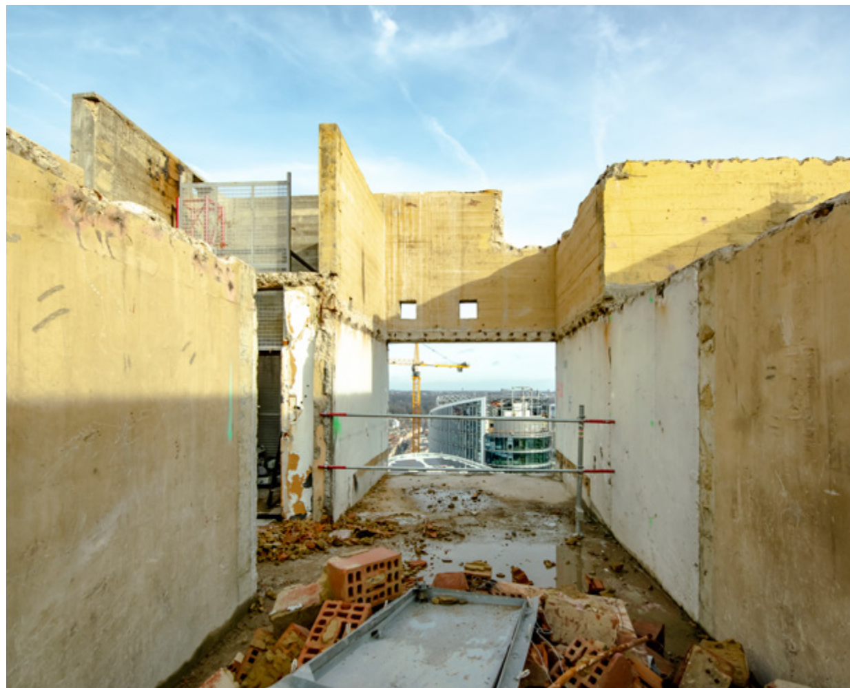
Chantier ZIN avec vue sur le chantier Quatuor - Bruxelles quartier Nord
