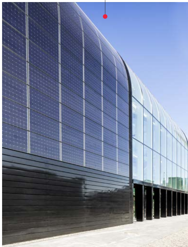
Immeuble de bureaux 'Bruxelles Environnement' (Port 86C) – Bruxelles CBD (BE)
