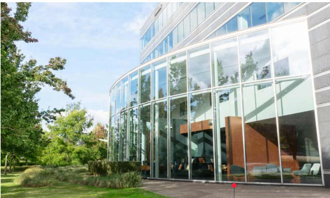
Immeuble de bureaux Bourget 50 – Bruxelles Décentralisé (BE)
