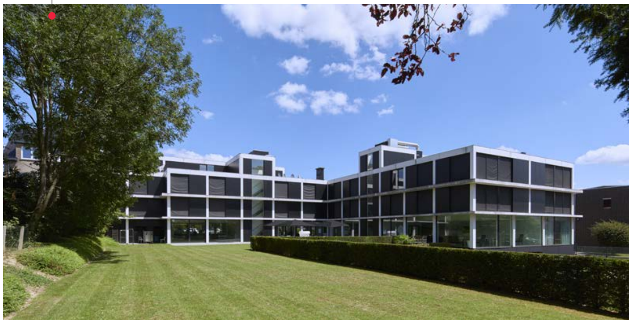
Maison de repos et de soins Dilhome – Dilbeek (BE)
