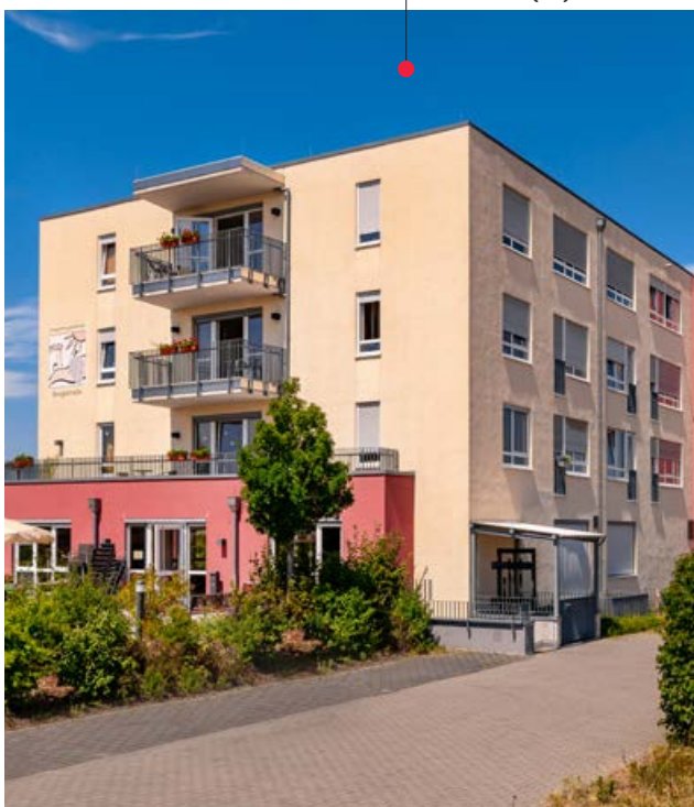
Maison de repos et de soins – Bickenbach (DE)
