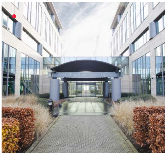
Immeuble de bureaux Park Lane – Bruxelles périphérie (BE)
