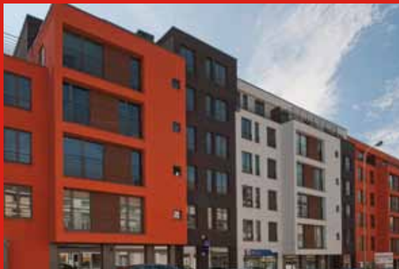
13 mai 2011 : 1 immeuble mixte : Résidence de Gerlache
