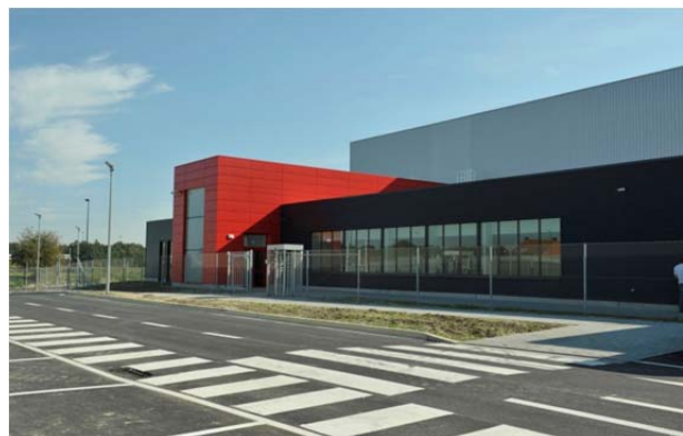
Montea « More than warehouses » - site Coca-Cola – Heppignies (Charleroi – België)
