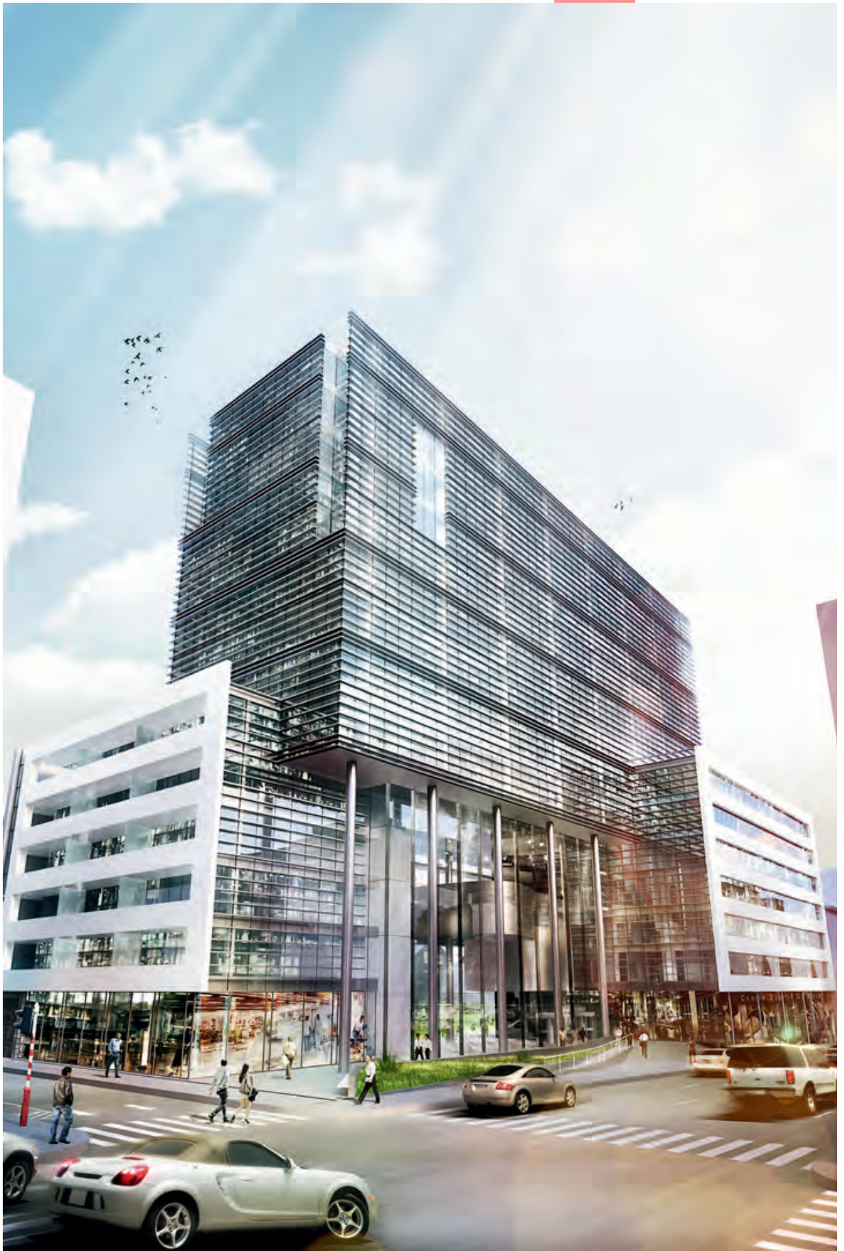
Science 15-17 - Bruxelles (après travaux : situation projetée)
