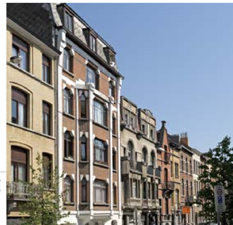
Louis Hap Immeubles à appartements - Bruxelles (Belgique)
