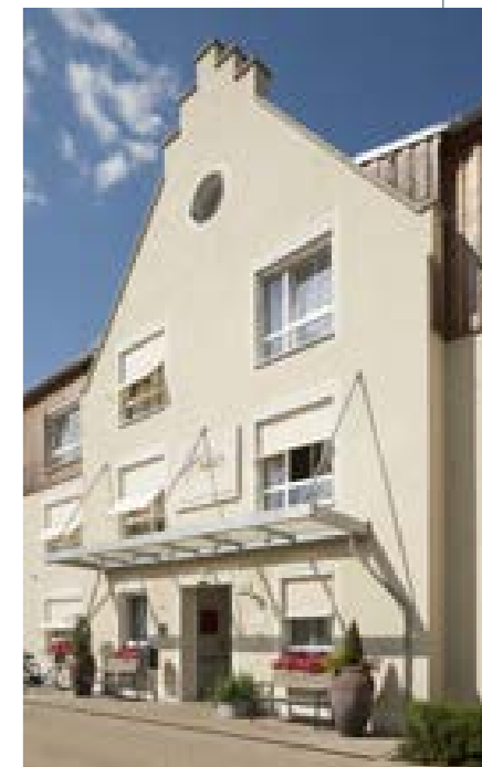
SZ AGO Kreischa Logement des seniors - Kreischa (Allemagne)
