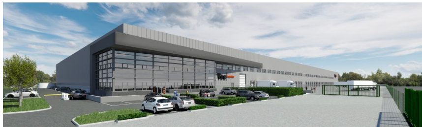
Montea «Space for Growth» - site Oss (NL)
