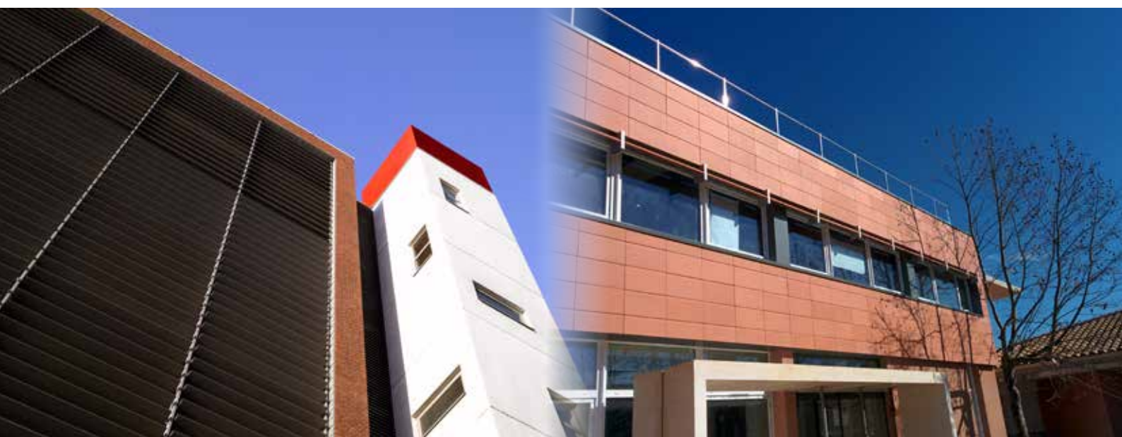
Caserne de pompiers, Anvers
