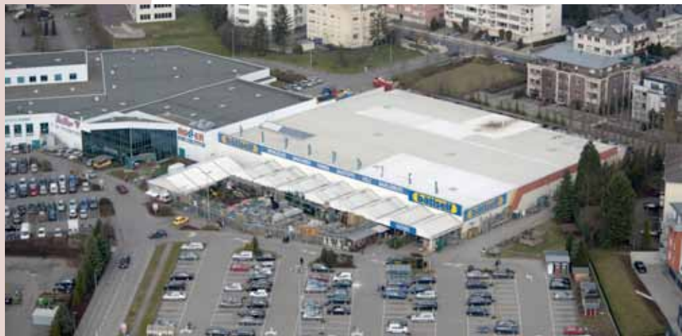
Route d'Arlon 2, Strassen
