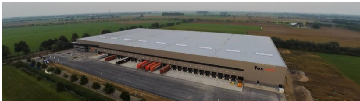
Montea «Space for Growth» - site Oss (NL)
