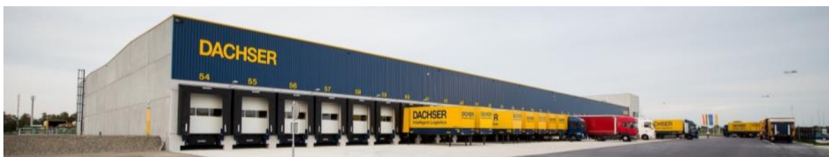
Montea «Space for Growth» - site MG Park De Hulst – Dachser (BE)
