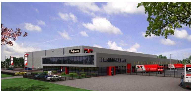
Montea «Space for Growth» - Site Tilburg (NL)
