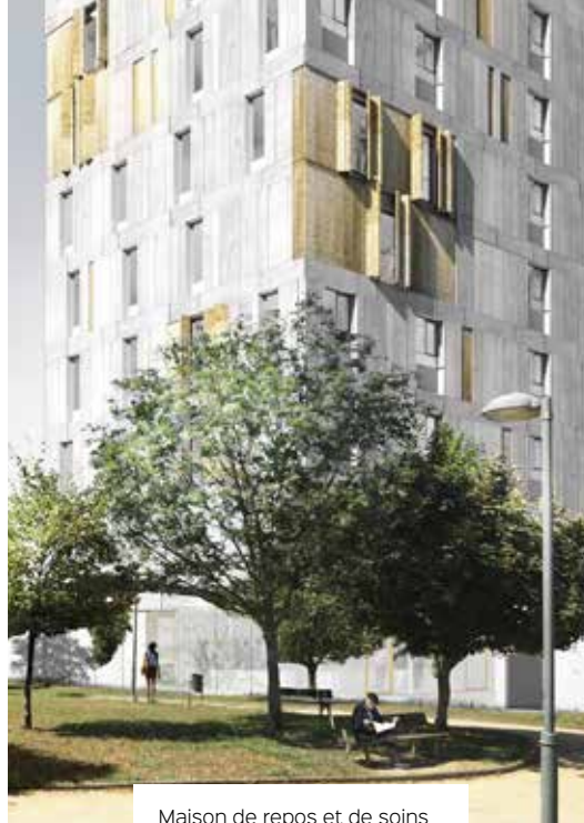
Maison de repos et de soins en construction – Vigo (ES)
