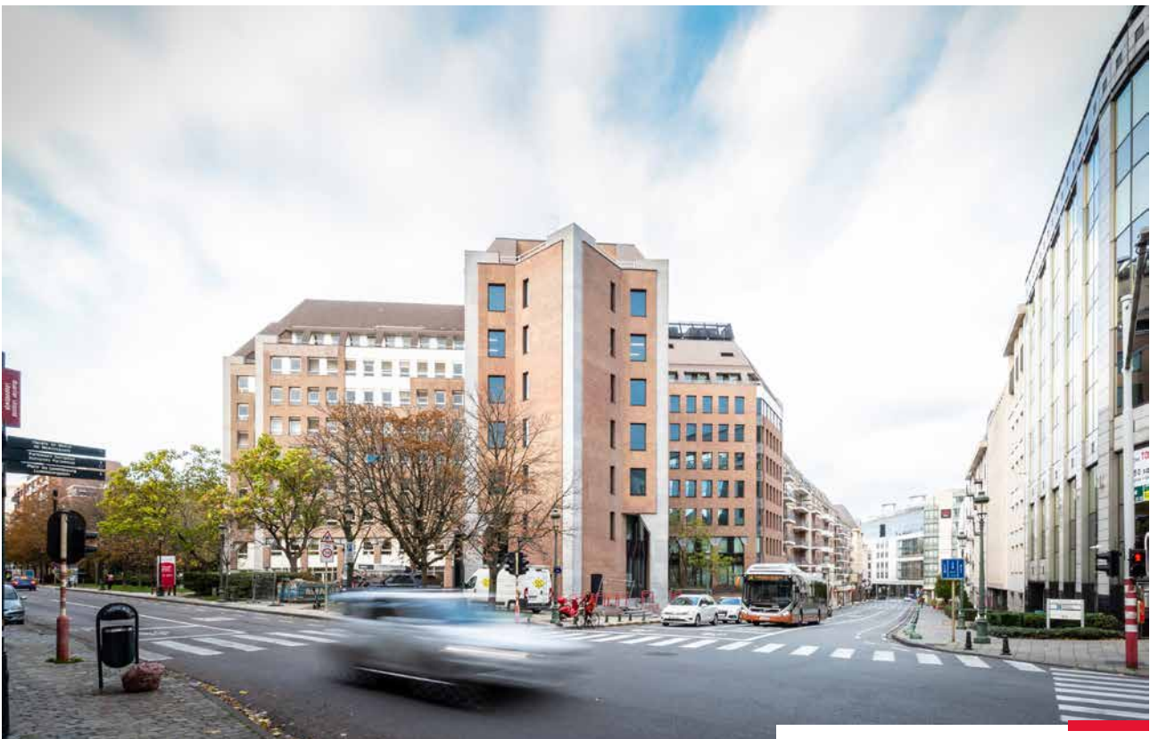
Immeuble de bureaux doté d'un centre médical Trône 100 – Bruxelles CBD (BE)
