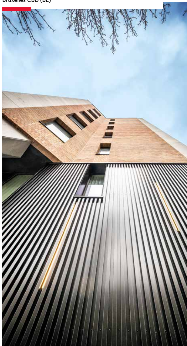
Immeuble de bureaux doté d'un centre médical Trône 100 – Bruxelles CBD (BE)
