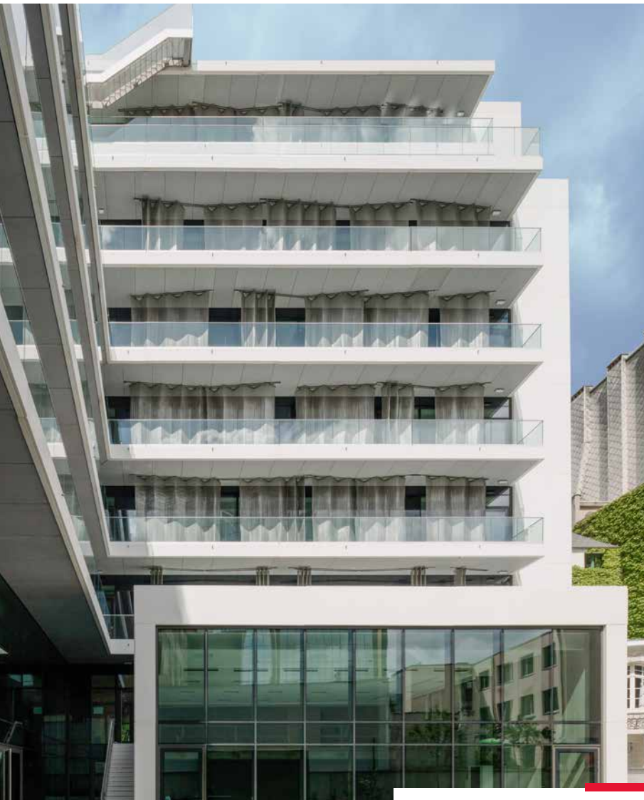
Immeuble de bureaux Quartz – Bruxelles CBD (BE) – BREEAM Excellent
